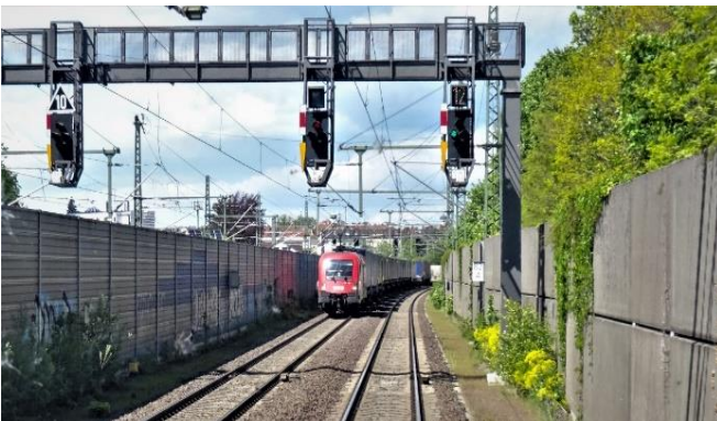
Schallschutzwände bei Neu-Ulm (Foto: DB AG)
